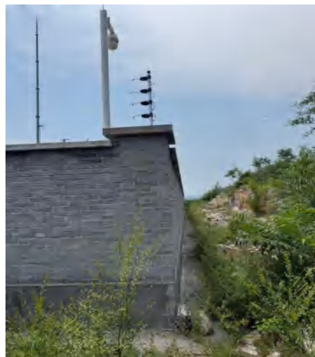
110kV 升压站西厂界
