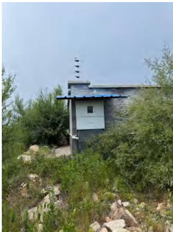
110kV 升压站南厂界
