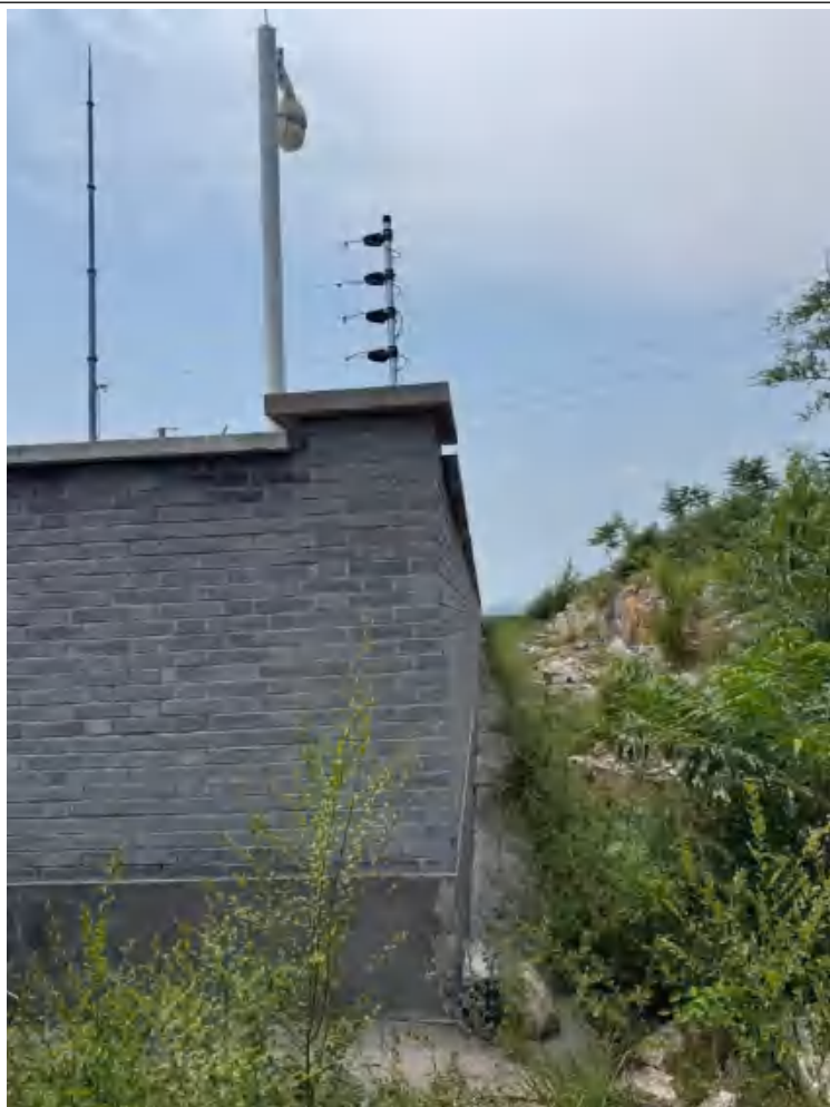
110kV 升压站西厂界
