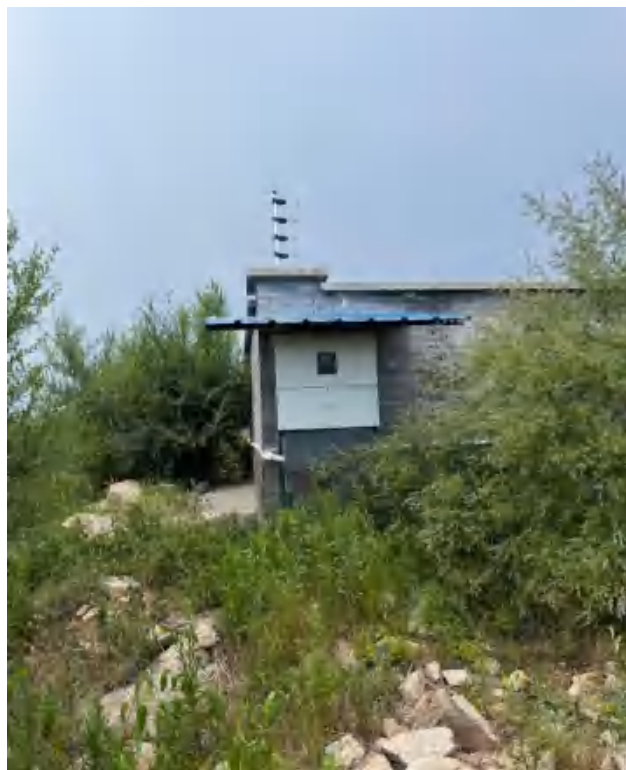
110kV 升压站南厂界
