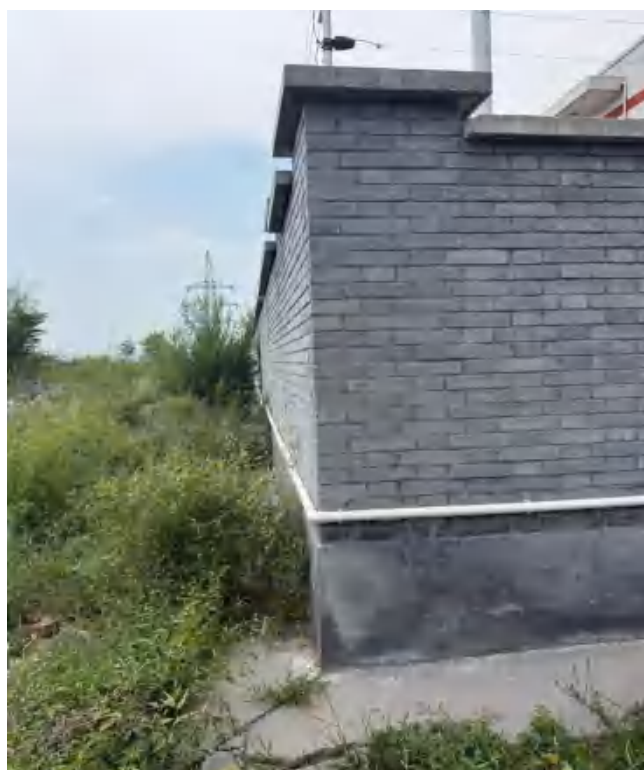
110kV 升压站东厂界
