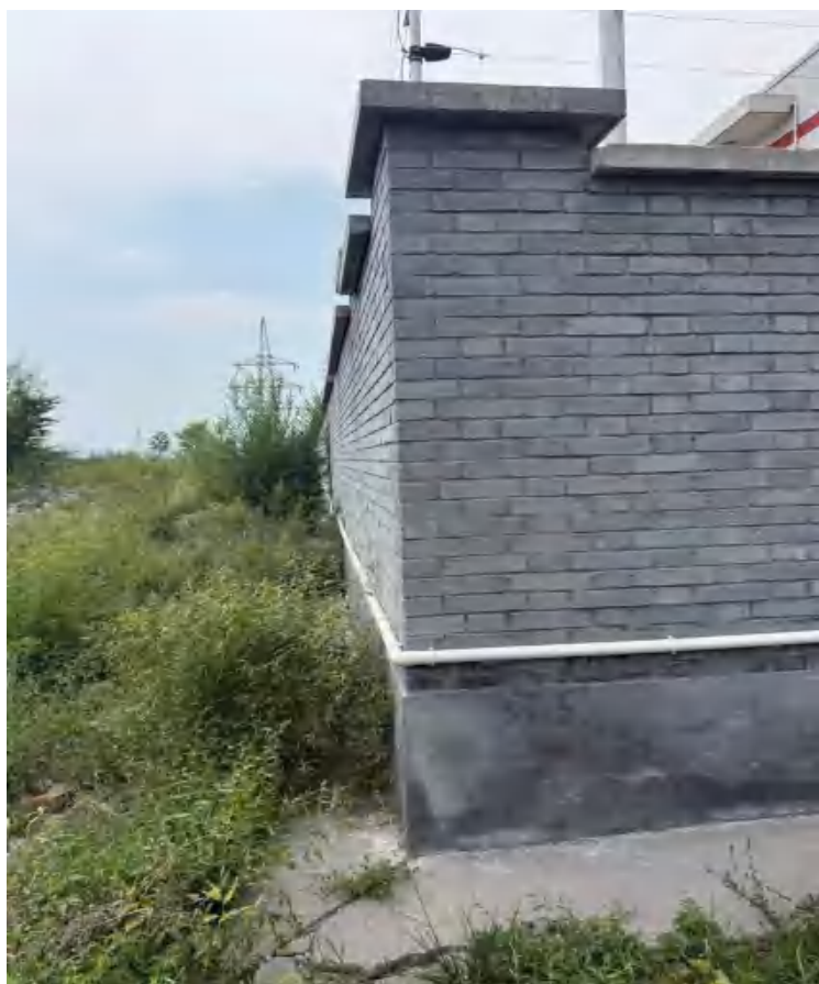
110kV 升压站东厂界
